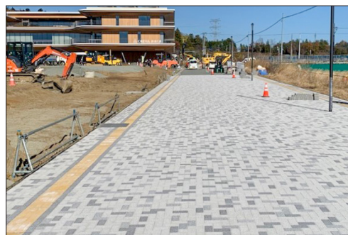
■ 工事が進む駅西の歩道部分
