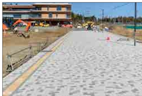
■ 工事が進む駅西の歩道部分
