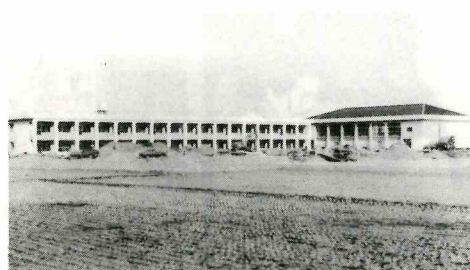
完成まじかの大野小学校全景
