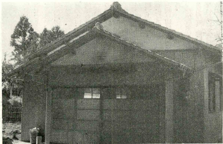
(写真は)大熊町公民館野上三区分館
