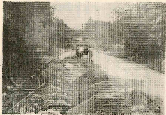
写真下 野上3区の火の見やぐらを越えて西に延びる山神前一大野駅道の舗装工事
