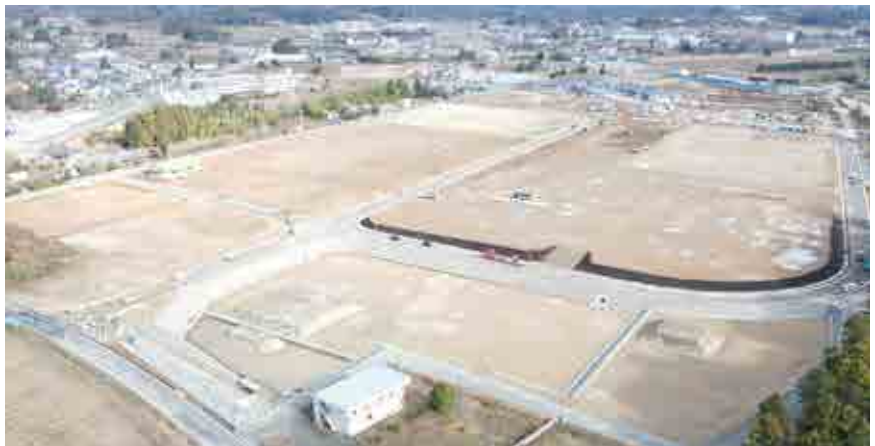
造成が完成した大熊中央産業拠点
