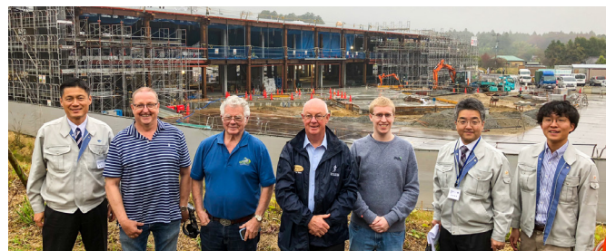
⑩新庁舎建設を視察するバサースト市使節団 (2018年)
