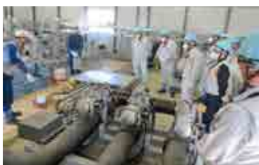
放出設備を確認する町担当者ら（東京電力提供）
