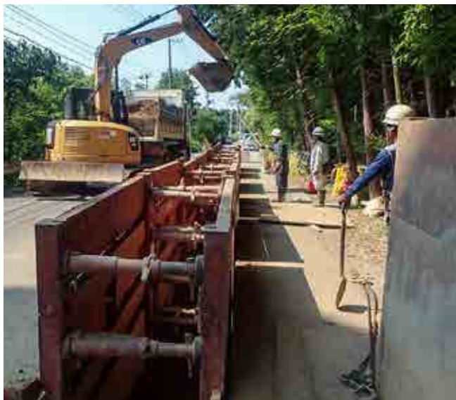
下水管工事を行っている町道東31号線の現場
