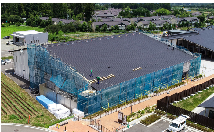
屋根に太陽光パネルを取り付ける準備をしている link 大熊
