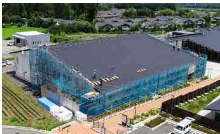
屋根に太陽光パネルを取り付ける準備をしている link 大熊
