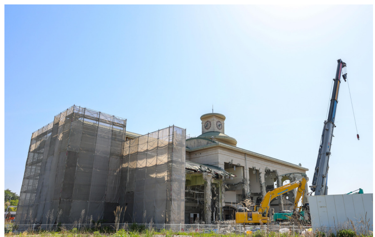
解体作業が進む図書館（令和5年5月撮影）
