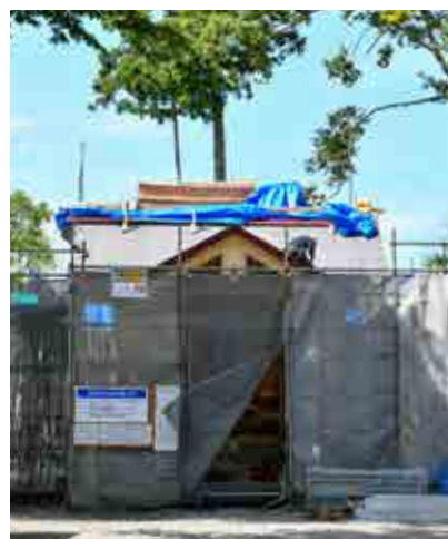
建て直しが進む初発神社（令和5年6月撮影）
