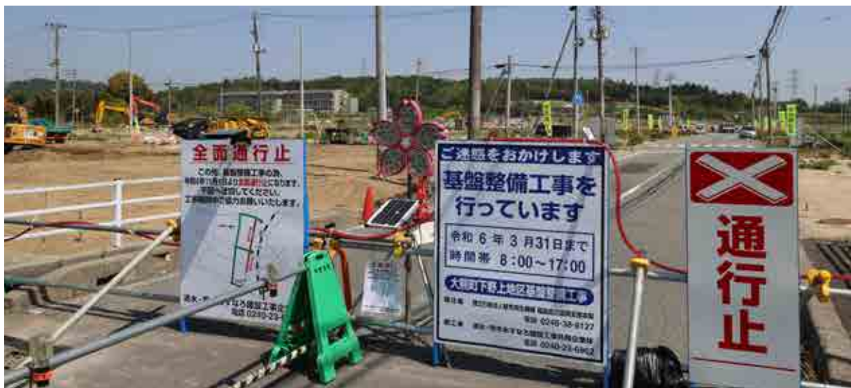
拠点基盤整備工事が進む駅西口周辺（令和5年5月撮影）
