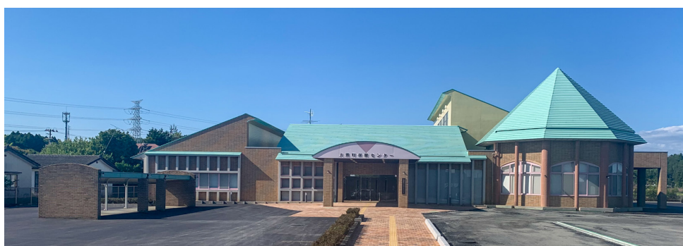
改修工事を行った町保健センター
