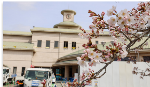
解体が始まった町図書館を見つめる桜
