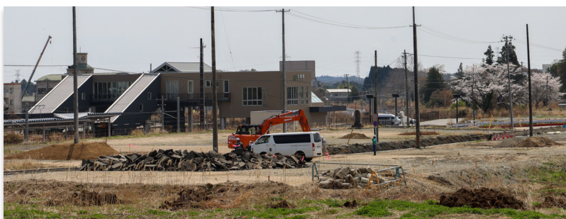
大野駅西で進む造成工事。右奥に西口の桜。ホーム側の桜は伐採されました
