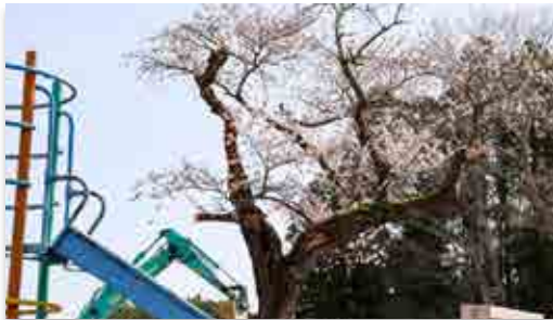
解体された大野幼稚園の敷地に残る桜
