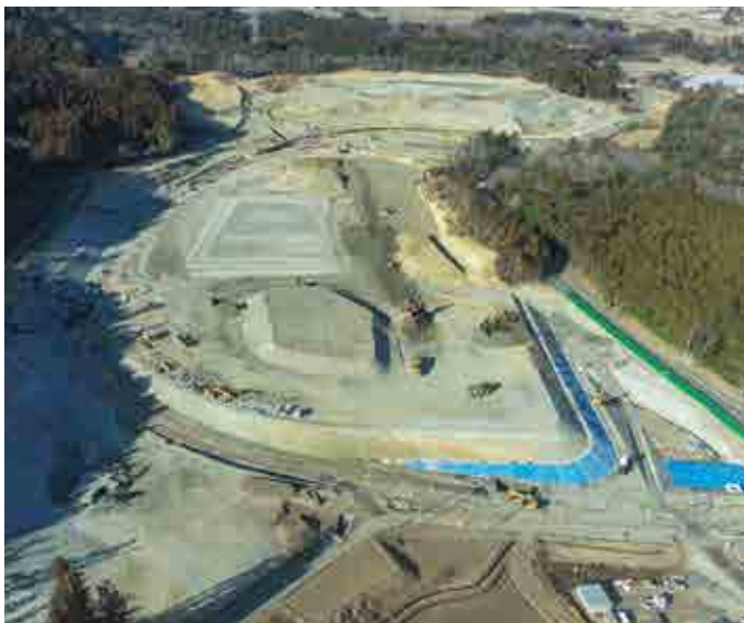
造成が進む大熊西工業団地
