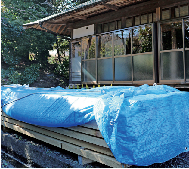
定住に向け自宅を修繕します
