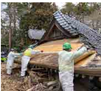
屋根の解体作業
