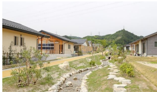
大川原公営住宅のせせらぎ水路
