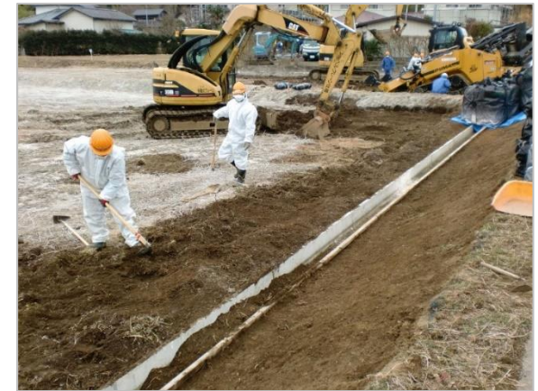
除染作業で表土をはぎとる作業員
