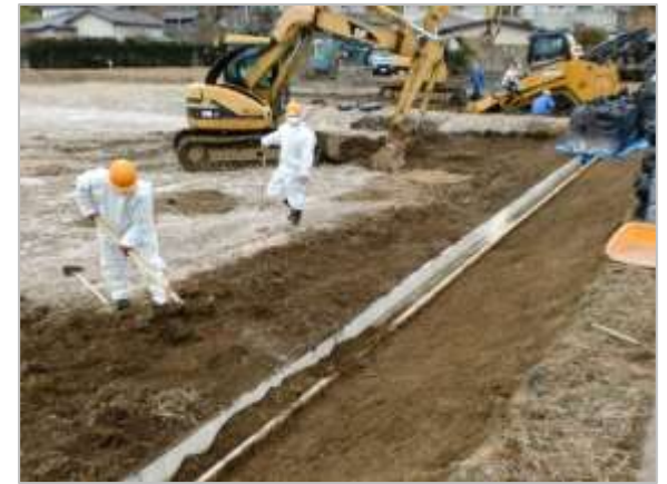
除染作業で表土をはぎとる作業員
