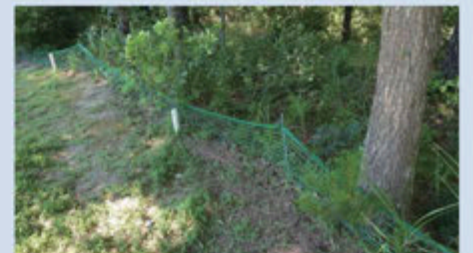
平成25年度市町村除染技術強化事業(福島県) 広野町の例
