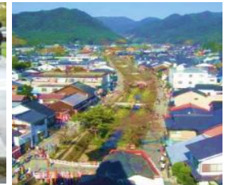
河川整備事業 (山口県 一の坂川)
