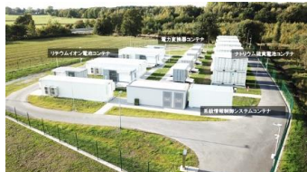
大規模ハイブリッド蓄電池システムの実証 ドイツのニーダーザクセン州でリチウム電池とナトリウム電池のハイブリッドシステムを構築（出所：NEDO）
