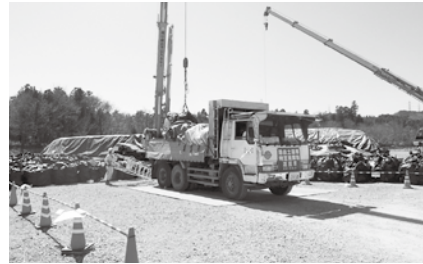
仮置場からの搬出作業状況
