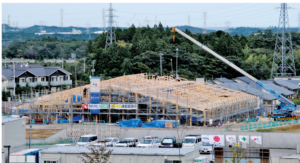
建設中の商業施設 早期の完成が望まれる
