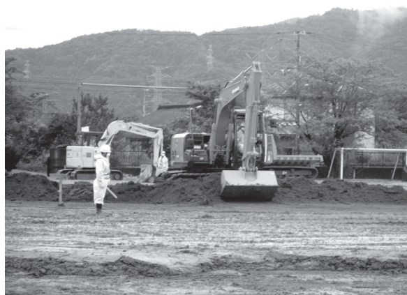
校庭の表土剥ぎ取り作業
