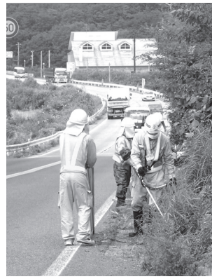
国道6号除草作業
