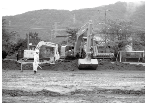
校庭の表土剥ぎ取り作業
