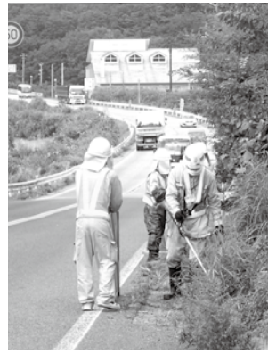
国道6号除草作業
