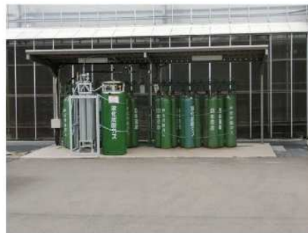
液化 CO 2 タンク
