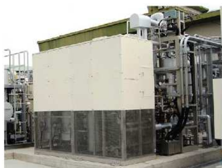
CO 2 液化回収設備全体
