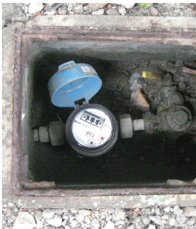
漏水をチェック
