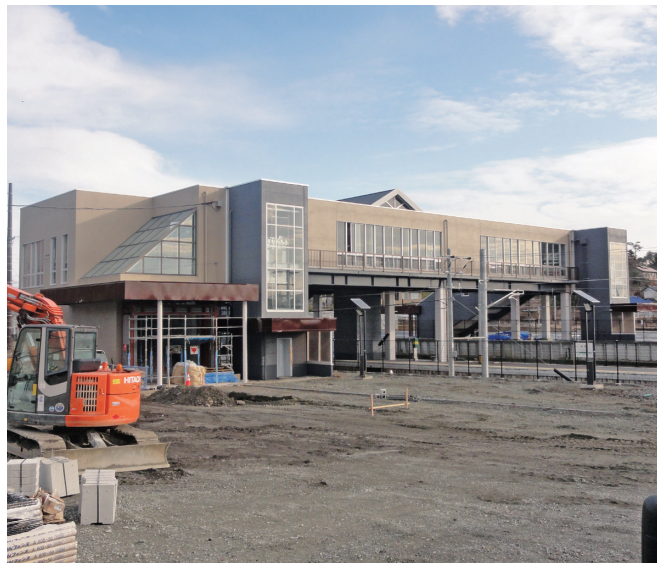
開業に向けて整備が進む大野駅
