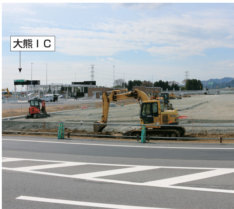
整備が進む大熊IC周辺駐車場
