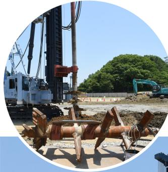
フル稼働中の地盤改良機。円内写真は先端の羽根部分で、直径1.5mと1.8mの柱状改良部があるため、付け替えて使用します
