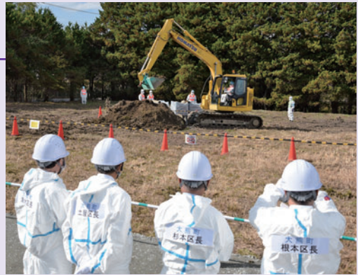
関係者が見守る中で始まった工事
