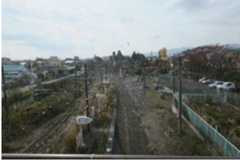
④大野駅舎の2階から南側を望む
