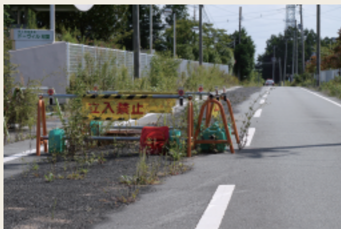
応急処理された町道
