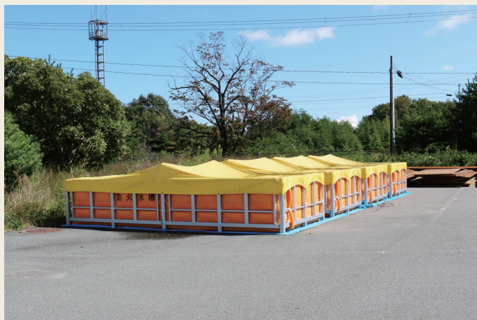
初期消火に有効 40mの水槽確保
