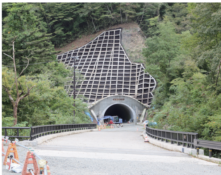
復旧が進む玉ノ湯トンネル
