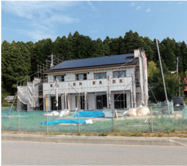
大川原に現在建設中の2世帯住宅
