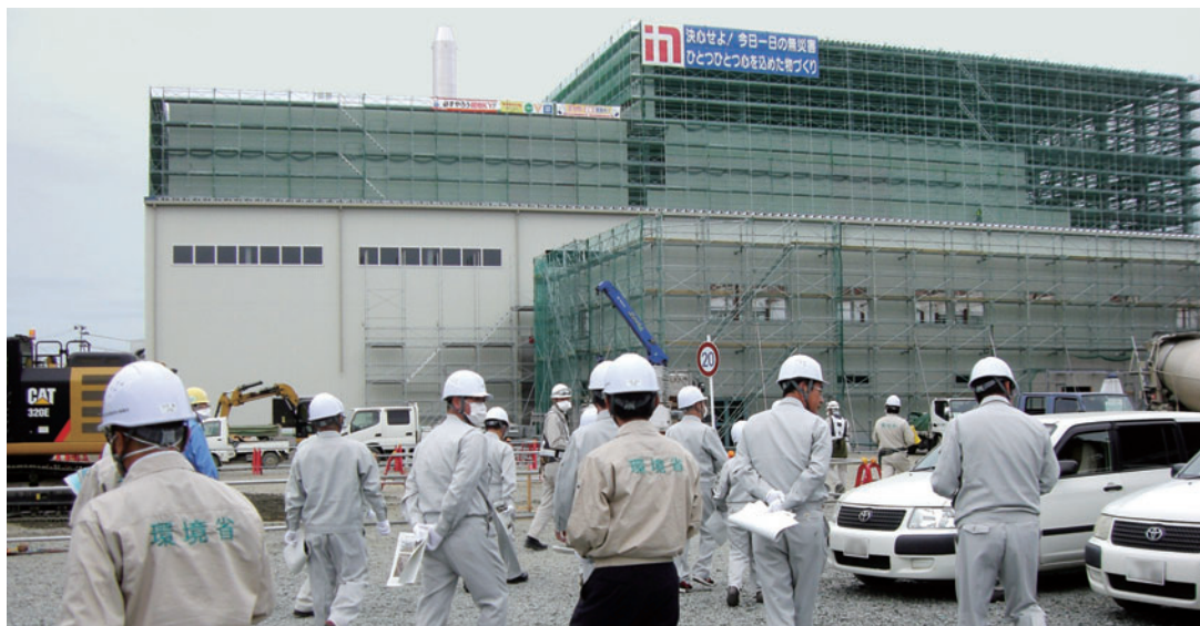
完成間近な仮設焼却炉 早期の運用が望まれる
