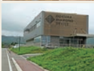
OICを経て大熊中央産業拠点に竣工した工場
