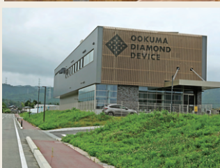
OICを経て大熊中央産業拠点に竣工した工場
