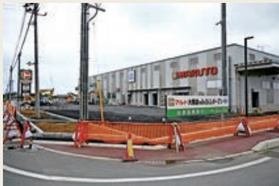
着々と開業準備が進むスーパーマーケット
