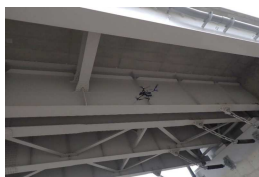
ドローンによる桁下の点検
