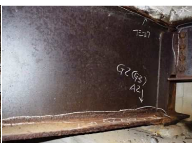
主桁の腐食
