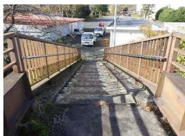
橋梁起点(旧町役場)方向
