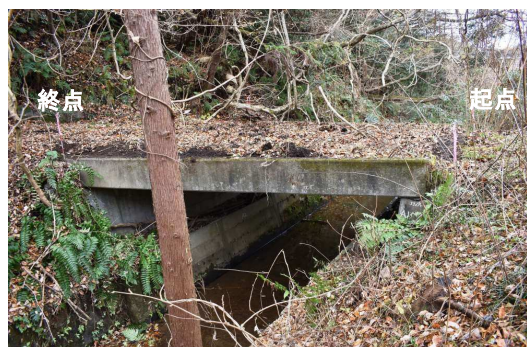
東106号橋 ：RC床版橋、橋長：5.04m 1径間、1987年竣工（38年経過） 町道東106号線、判定区分：[I] 帰還困難区域
