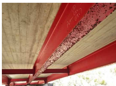
主桁の腐食
