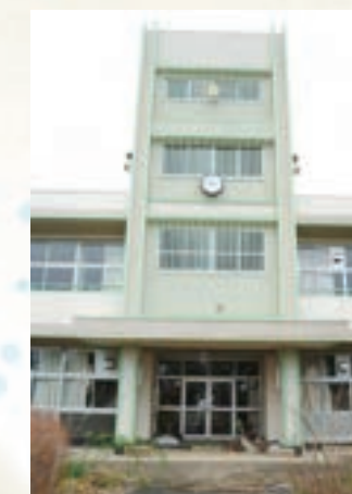
【①建造物の例】熊町小学校
