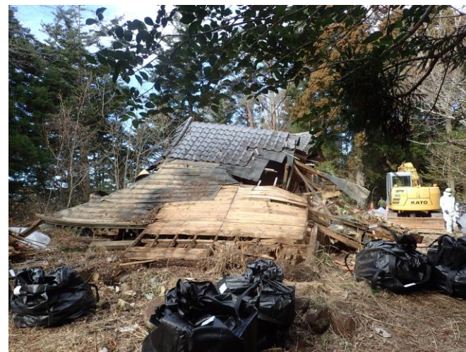
山神社 解体前
