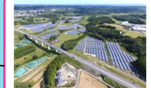
大熊エネルギー・メガ ソーラー発電所 8600kW
