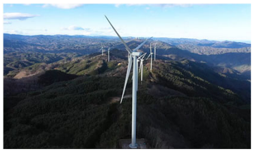
阿武隈風力発電所 9600kW
