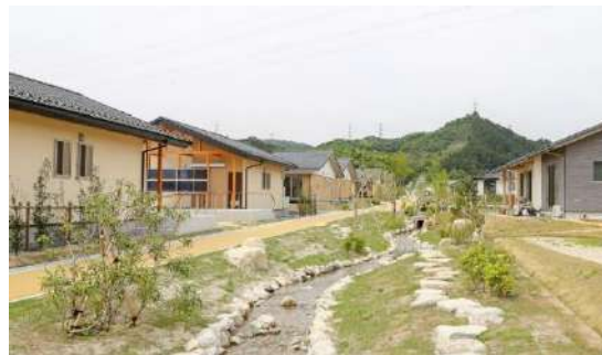
大川原公営住宅のせせらぎ水路
