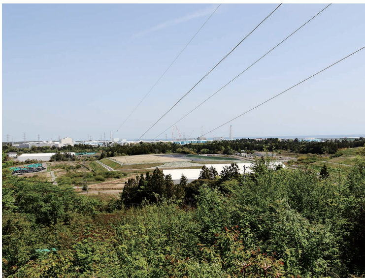
搬出を待つ大熊4工区貯蔵施設
