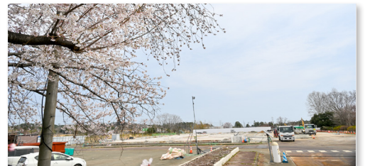
旧役場庁舎の解体工事を見守る桜
