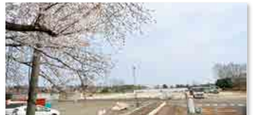
旧役場庁舎の解体工事を見守る桜
