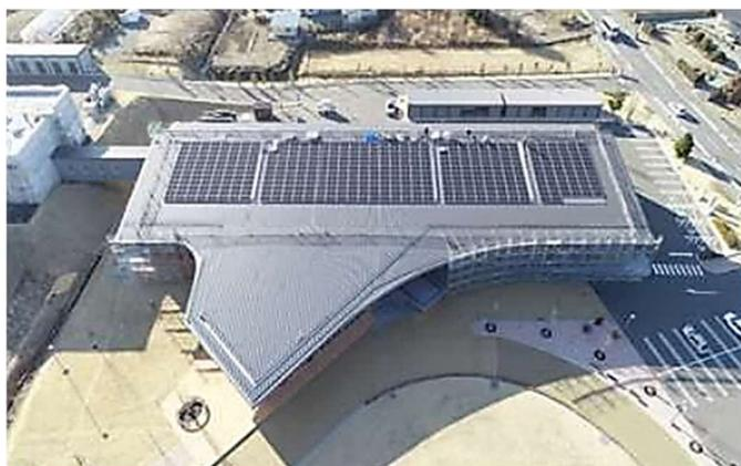
図9 本町公共施設（町役場）屋根の太陽光発電導入例
