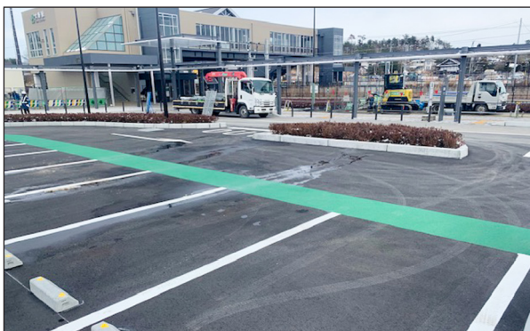
■ 完成した西口ロータリーと駐車場
